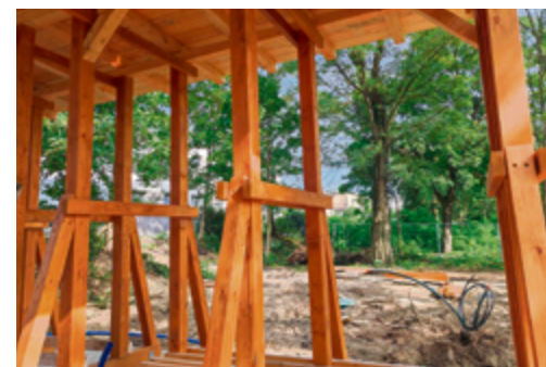
Przy kompleksie przedszkolno - żłobkowym na ul. L. i M. Kaczyńskich budowana jest tężnia solankowa. Teren będzie na nowo zagospodarowany.
