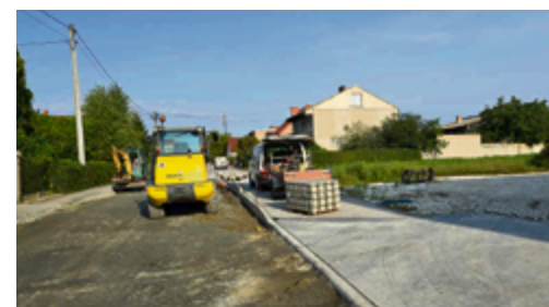
Zakończono budowę kanalizacji deszczowej i sanitarnej w Izbicach. Trwają przygotowania do położenia nawierzchni asfaltowej.
