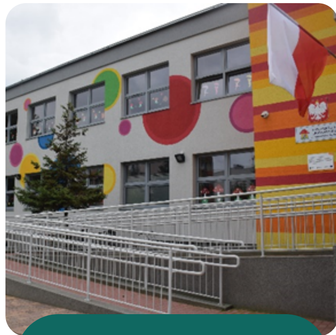
MONTAŻ INSTALACJI FOTOWOLTAICZNEJ NA BUDYNKU PRZEDSZKOŁA NR 5 „POD GRZYBKIEM”
