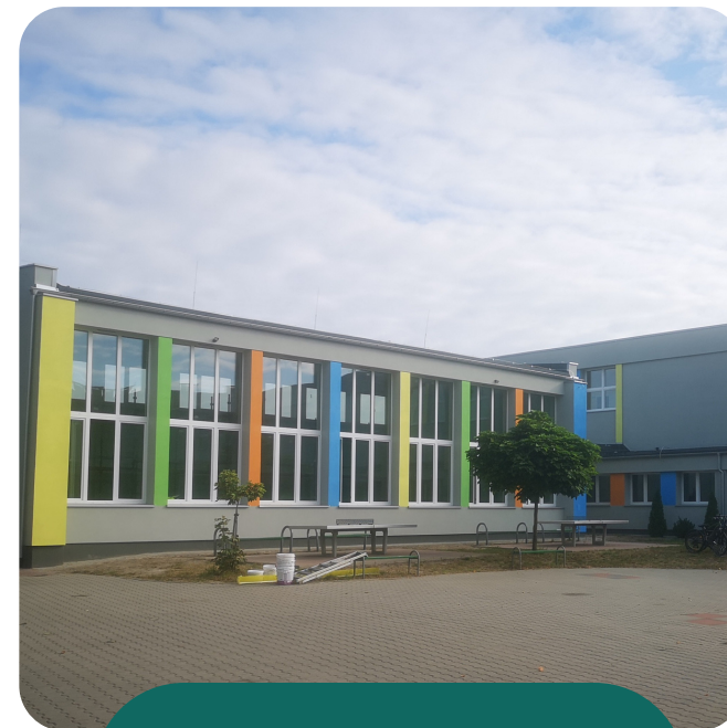
TERMOMODERNIZACJA SZKOŁY PODSTAWOWEJ NR 4
