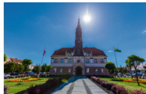
Ratusz w Sarnowie - rozpoczęcie prac renowacyjnych.
