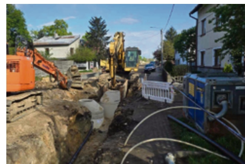
Przebudowa drogi gminnej w Izbicach - trwa budowa kanalizacji sanitarnej.
