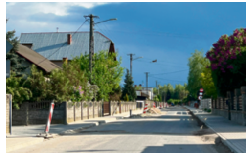
Przebudowa ul. Żniwnej w Masłowie - trwa realizacja zakresu drogowego.
