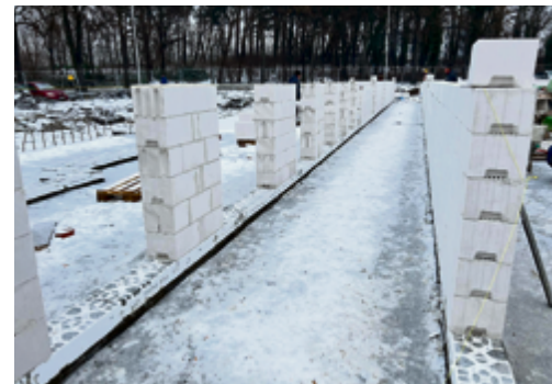
Nowe przedszkole przy dworcu PKP ma już zarysowane mury.
