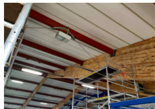
Postępują prace remontowe (naprawcze) w sali sportowej szkoły w Sierakowie.
