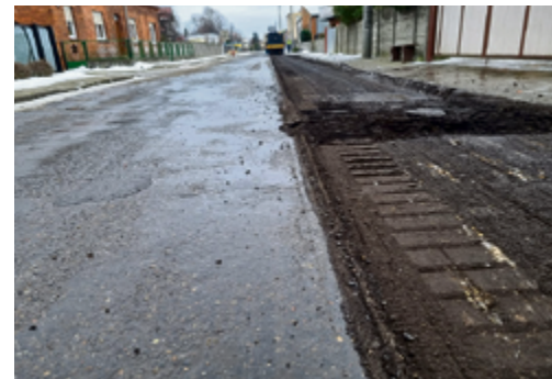
Ruszyła przebudowa drogi w Izbicach.
